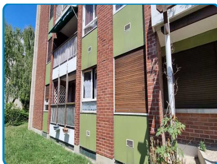
ZH sur D.O. n° 1 sur Allège Fibres ciment
